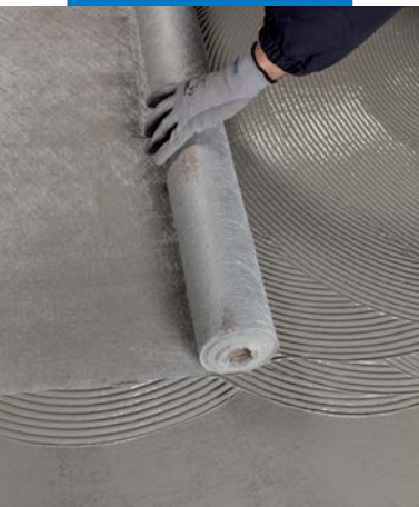
Postavljanje Mapenet-a Sel na prvi sloj Mapelastic-a Turbo
