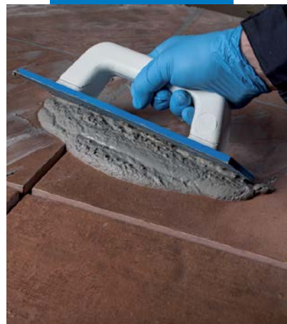
Fugovanje pločica sa Ultracolor Plus-om
