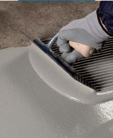
Nanošenje prvog sloja Mapelastic-a Turbo
