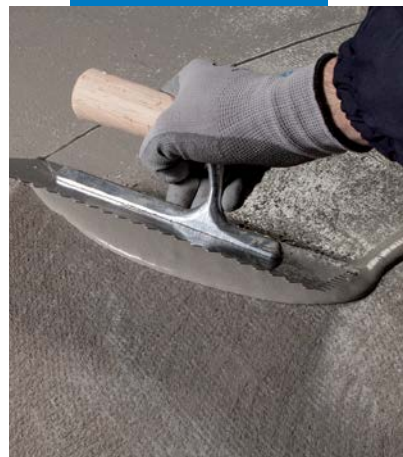
Nanošenje drugog sloja Mapelastic Turbo-a preko prvog sloja ojačanog sa Mapetex-om Sel
