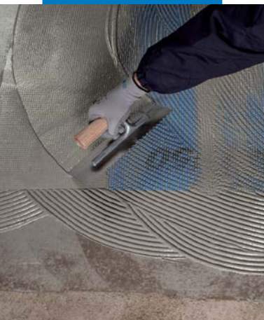
Postavljanje Mapenet-a 150 na prvi sloj Mapelastic-a Turbo
