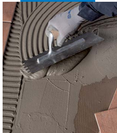
Lepljenje pločica sa Elastorapid-om
