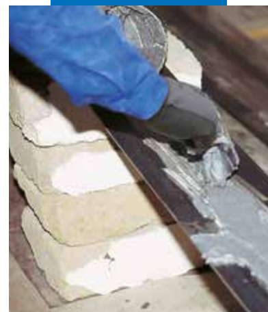
Nanošenja Adesilex-a PG1 na čeličnu ploču
