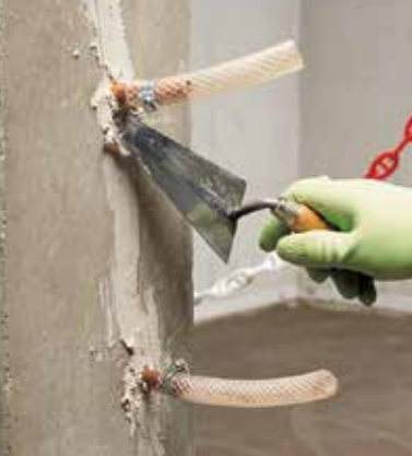
Fiksiranje injektorskog creva i zapunjavanje pukotine radi konstrukcijskog ojačanja
