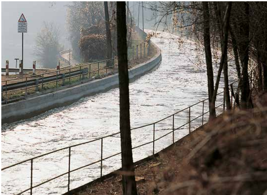
Kanal hidroelektrane Bertini - Como, Italija. Površina obrađena sa Planiseal 88
