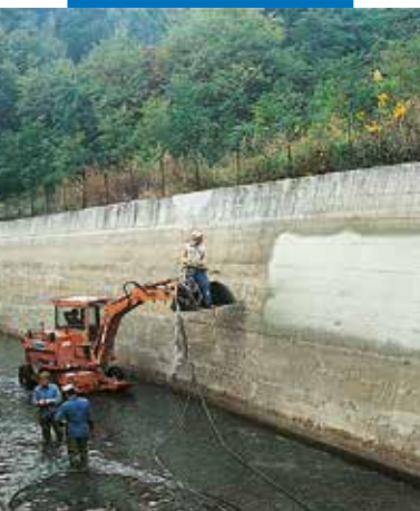
Nanošenje prskanjem Planiseal 88 u kanalu hidroelektrane
